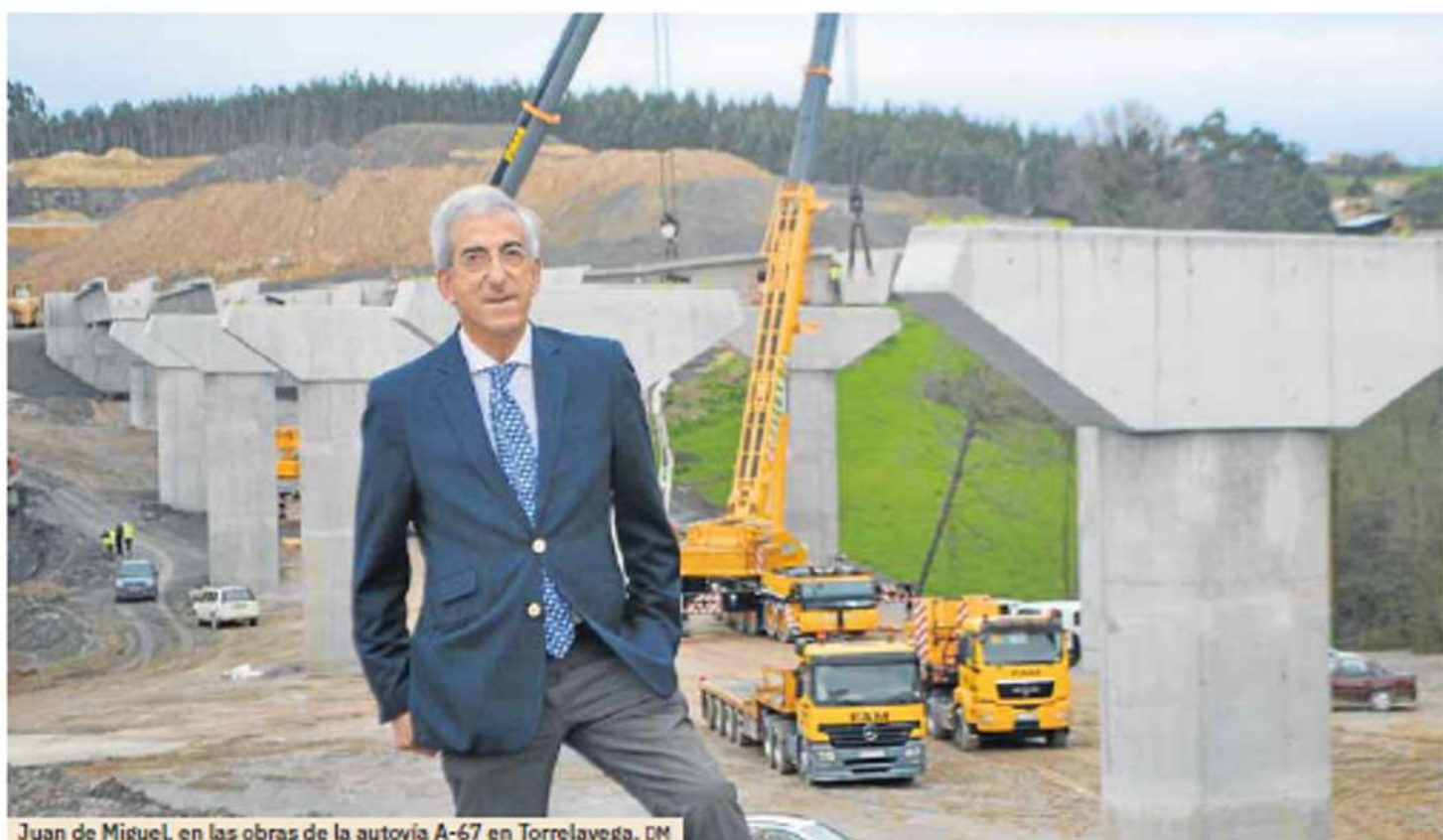
Juan de Miguel, en las obras de la autovía A-67 en Torrelavega. DM
